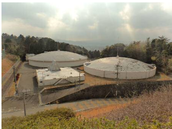
雉子ヶ尾低区配水池
