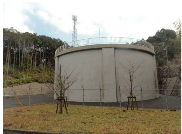
牛頸高区配水池
