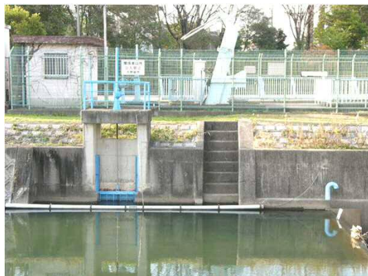
牛頸川取水場(統合堰)
