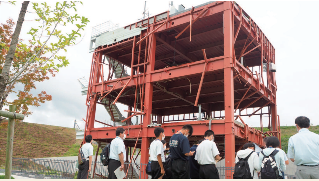
▲南三陸町防災対策庁舎跡地（3日目）
